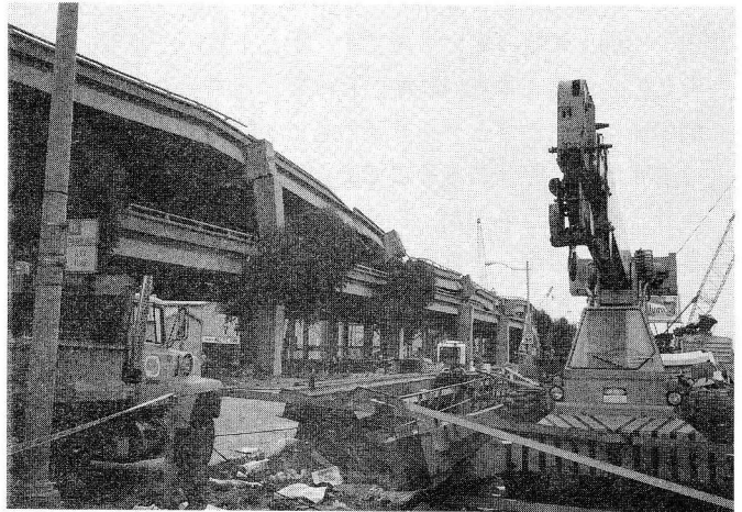
崩壊した高速 880 号線 (オークランド)
