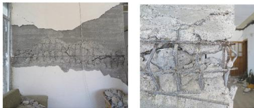
写真 1 RC 造壁の被害
