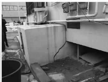
図3 約1.2m噴砂が発生した建物基礎
