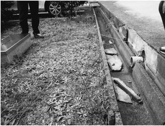
写真2 湯梨浜町龍島（東郷支所）震度計周辺の様子
