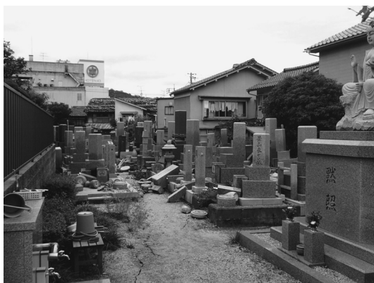
写真 1 倉吉市街における墓石の倒壊と後方に屋根瓦の落下被害
