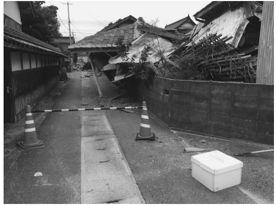
写真3 北栄町内における木造建屋の倒壊
