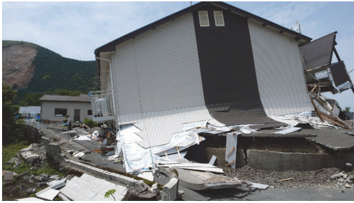
図 3 南阿蘇村での木造アパートの被害
