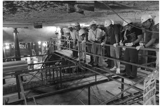
写真 4 免震化耐震改修工事現場（つくば市）の視察
