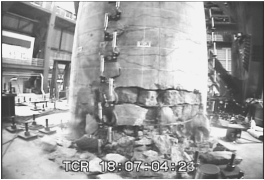
写真 5 1970年代の基準で設計された橋脚の破壊（主鉄筋段落としてはされていない、5回目の加振）
