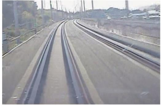
図 23 脱線防止ガードの敷設状況（本線）。
