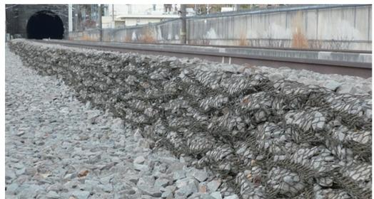
図 26 ジオテキバッグ工法の敷設状況。
