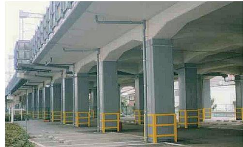
図 2 高架橋標準補強工法（鋼板巻き補強工法）.
