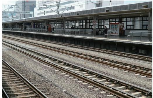
図 24 脱線防止ガードの敷設状況（駅構内）。
