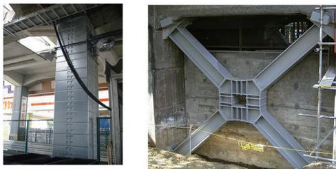
鋼板パネル組立工法 ダンパーブレース工法
