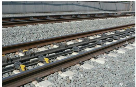
図 25 脱線防止ガードの敷設状況（転換時）。
