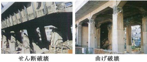
図 1 兵庫県南部地震での RC 高架橋の被害<sup>1)</sup>.
