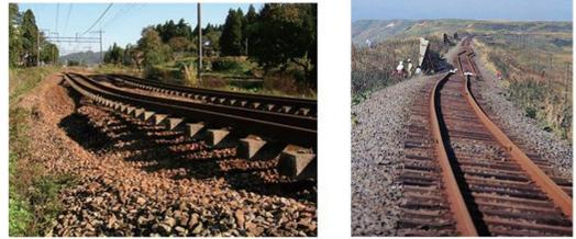
図 5 支持地盤を含む円弧すべり (新潟県中越地震)<sup>2)</sup>。
