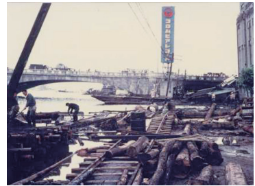
写真 4 萬代橋周囲の被災状況 (渡辺隆博士撮影)
