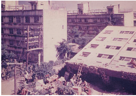
写真 5 沈下・傾斜した川岸町県営アパート（渡辺隆博士撮影）
