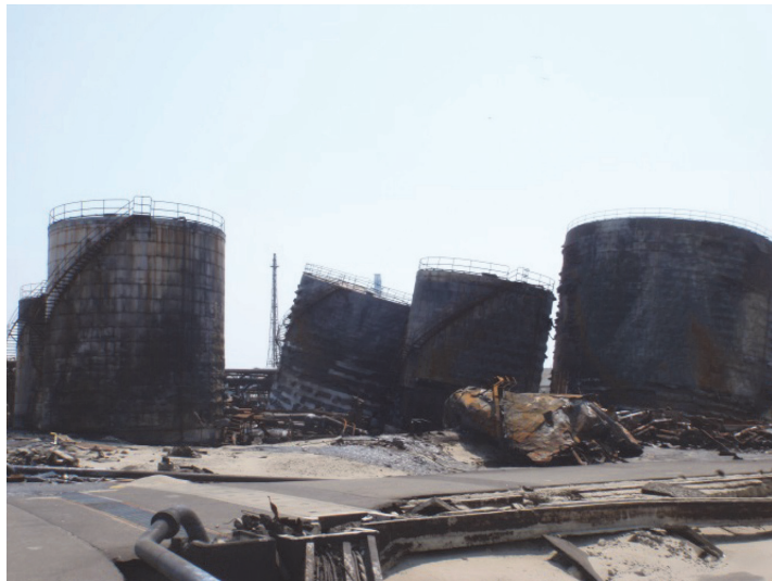
図 5 アスファルトタンクの被害状況（筆者撮影）
