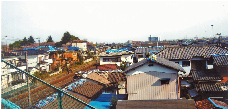
写真 1 JR 鴻巣駅南の陸橋から見た中心市街地の屋根瓦被害
