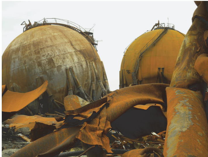
図 6 LP ガス球形タンクの被害状況（筆者撮影）
