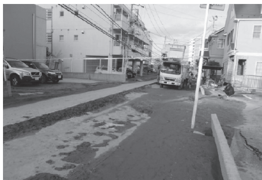
写真 2 道路の被災例（浦安市）
