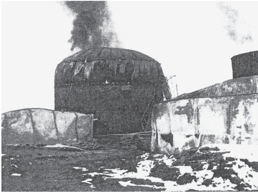
写真 2 外部から火炎を浴びたガソリン貯槽（非着火）〔文献（1）〕
