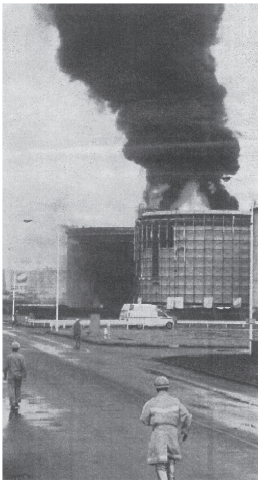
写真 3 地震後、数日後の固化した消火剤泡と壁間の雷よう放電による油火災の写真と思われる(苫小牧) ©日経新聞社
