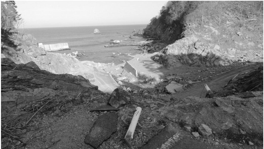
図 5 津波遡上高さ 37.9m を記録した小堀内漁港
