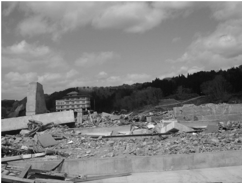
図 8 完全崩壊した田老町の新防潮堤
