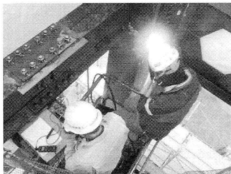
(2) 現場溶接接合部
