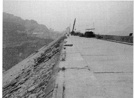
図 13 紫坪舖ダム（左：上流側遮水版に亀裂が発生，右：下流側堤頂フェンスが倒壊）
