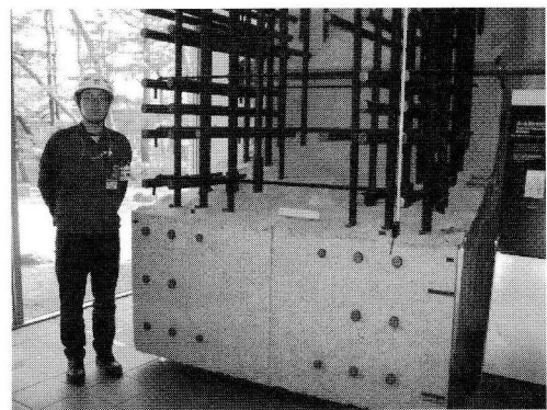
写真7 その厚いRC壁の内部には，写真のように直径51mmの太い鉄筋が林のように組まれていて，地震力に対して粘り強さを増し，安全余裕を高めている。（東京電力提供）
