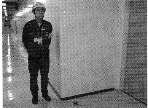
写真6 しかし，前記3機能に直結する原子炉建屋（Aクラス）では，厚さ1.5mものRC壁で重要機能を守った。（東京電力提供）
