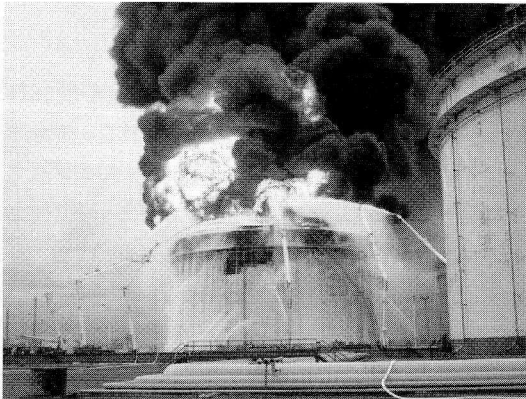
写真 3 2003年十勝沖地震後、浮屋根が沈没し全面火災に至った3万klナフサタンク
