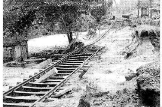
写真4 線路の基礎が津波により大きく侵食
