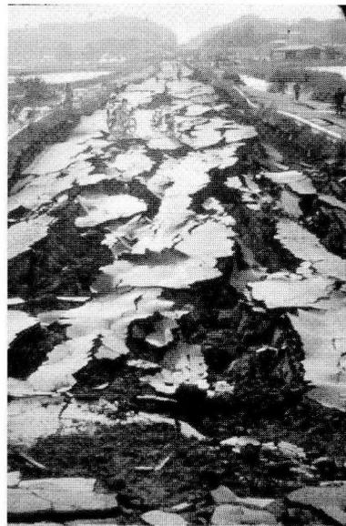
写真2 液状化により崩壊した五明光橋取付け盛土
