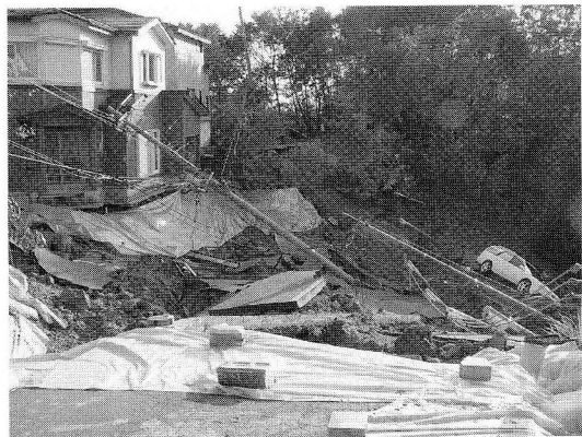
写真 4 長岡市造成地の崩れ
