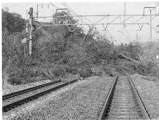
写真 5 崩落土砂による線路の埋没
