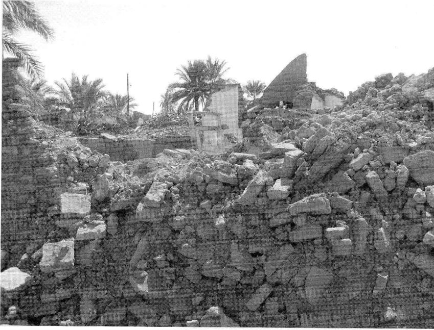
日干しレンガ造住居の崩壊、やしの木、電柱は無被害、イラン・バム地震 2003
