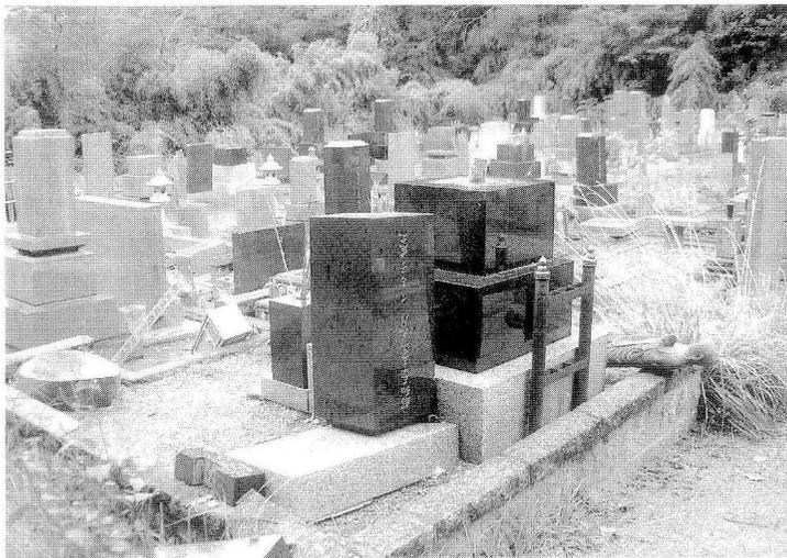
写真 3 写真2を裏側から見た状況。台座に残った径5cm、長さ15cmの固定用心棒は折れていない。墓石が上に向かって飛び上がりすぐ横に頭部から逆さに落下したことを示す。
