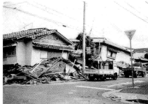
典型的な倒壊家屋、神戸市東灘区1995年兵庫県南部地震
