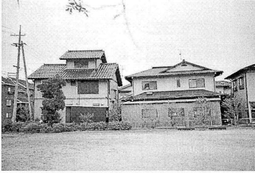
写真 1 米子市安倍彦名団地で液状化により不等沈下した家屋
