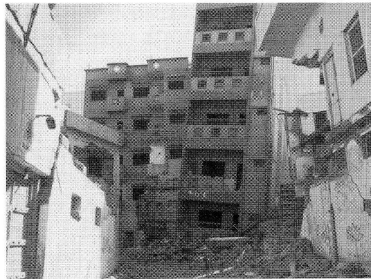
写真 2 ブージ旧市街の被害状況
