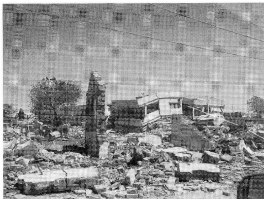
写真 1 バチャウ市内の被害、RC 構造物と組積造の倒壊
