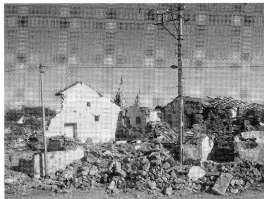
写真 6 組積造住宅被害、ロリア村
