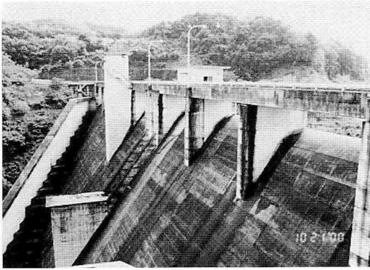
図 3 地震後の賀祥ダム，底部に 500 ガル以上の加速度を受けたが，堤頂の機械室の窓ガラスが壊れただけで本体は何ともない。
