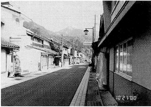
図 1 1,400 ガル以上の強震動を観測した日野町役場近くの下黒坂の町並み。相当ガタガタになってはいるが倒壊家屋はない。
