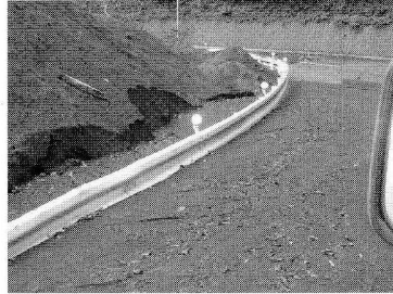
図 7 山腹に積もった火山灰は、雨が降るたびに泥流となって流れ下る。数十 cm の厚さの泥で道路が覆われると、4 輪駆動車でも通行が困難となる (ガードレール、人の足、車のタイヤに注目)。
