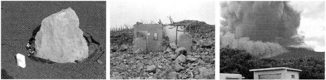
図 4 (左) 7月8日の陥没によって飛ばされた噴石が、登山道終点の駐車場（アスファルト舗装）にめり込んでいた。このときはまだ、アスファルト舗装面は95%露出し、トイレの建物も無事であった（7月11日撮影）。(中央) 7月14-15日の水蒸気爆発で飛ばされた無数の噴石は、登山道終点の駐車場を爆撃した。アスファルト舗装面は厚さ50cmほど噴石で覆われ、トイレの建物および背後の立ち木の破壊が生々しい（7月31日撮影）。引き続き陥没により、この場所も数日後には火口に呑み込まれて、今はない。(右) 北部の三宅島測候所から見た8月10日の噴火。火砕サージが山腹を流れ下っている。中央には火山雷が写っている。
