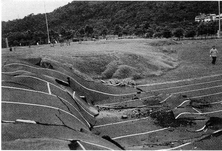
写真 8 霧峰の光復国民中学裏のグラウンドに現れた地震断層による撓曲崖（地点5）
