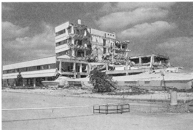
写真3 アスランベイ市にあるゴジャエリ大学の造営中の新キャンパス内の建物の被害
