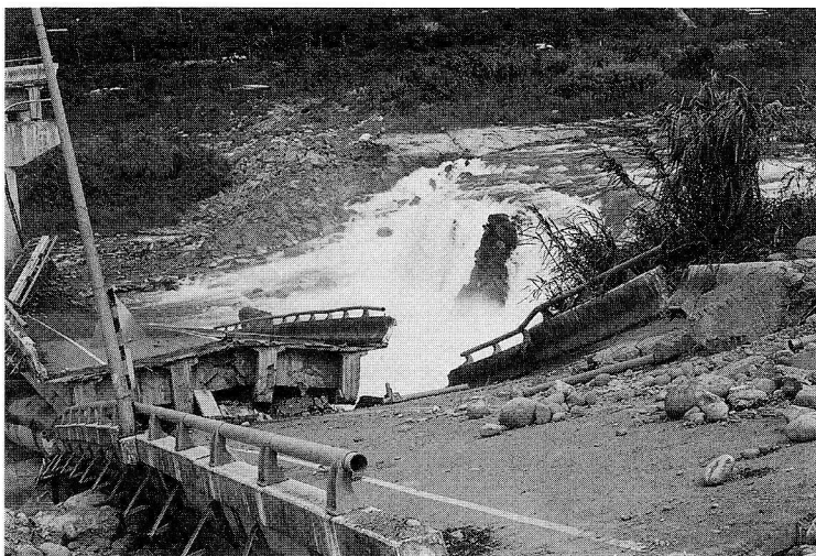
写真 4 大甲溪埤豊橋の破壊とその付近の河床に地震断層で形成された瀧（地点3）
