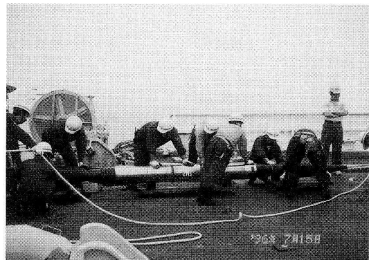
図6 ケーブル敷設船上で設置作業中の海底津波計（三陸沖システム）。
