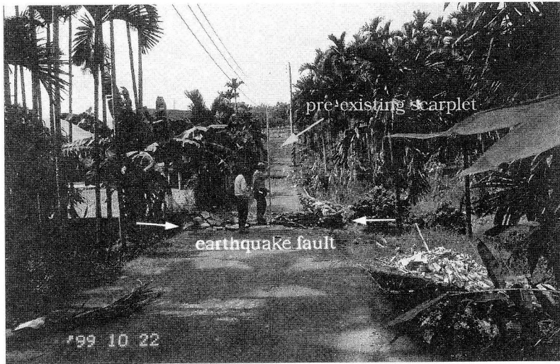
写真 12 草屯東方，富州橋北側の西上りの地震断層．既存の活断層と一致する．
