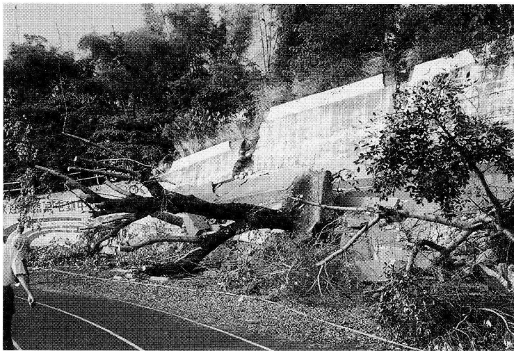
写真 11 草屯商工グラウンド背後の東上がりの地震断層。既存の活断層と一致する（地点6）。
