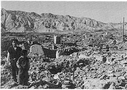
写真 2 日干しレンガ住居は全部崩壊した。電柱は立っている。
