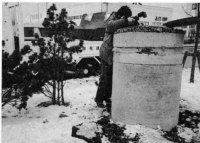
図1 液状化によるマンホールの浮き上がり（釧路市）
