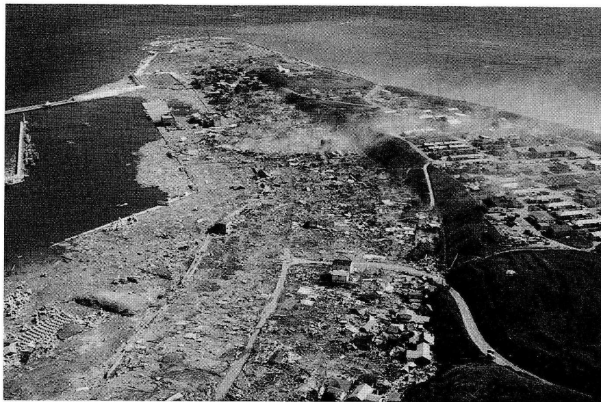
図2 津波と火災に襲われた奥尻島青苗地区
