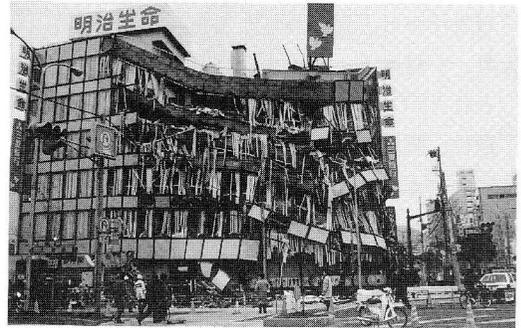
凄まじく崩壊したビル 兵庫区新開地でも建物の東南角が崩壊した。[佐藤工業(株)中央技術研究所：提供]
