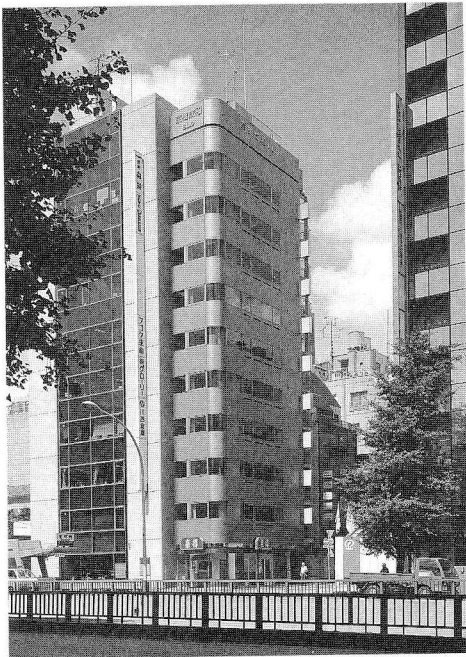
写真1 京橋成和ビル
