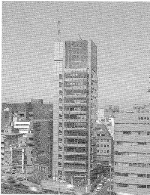
写真3 安東錦町ビル
