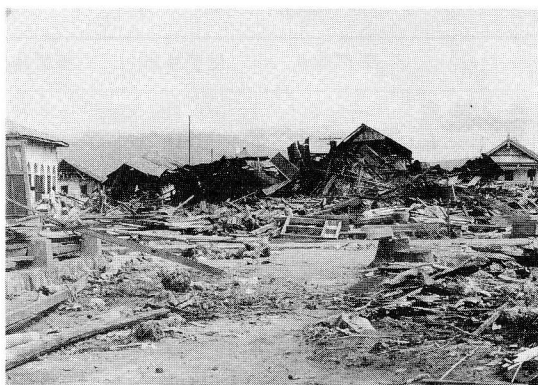
写真3 Wuring 地区での被災状況 この地区は奥尻島青苗地区の地形や被害の程度と類似している。
