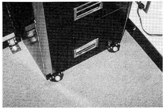
写真4 書類ファイルケースの床への固定
