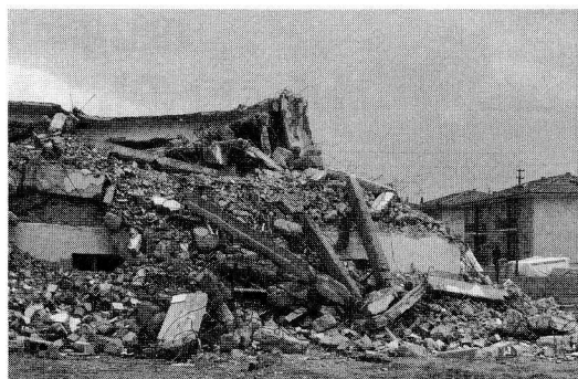
写真1 5階建の鉄筋コンクリート建物の崩壊 エルジンジャン市内の高校。
