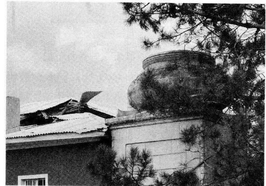
写真5 ミナレ（尖塔）の崩壊 台座上約20mの石積みのミナレが崩壊し、礼拝所の信者25人の命を奪った。
