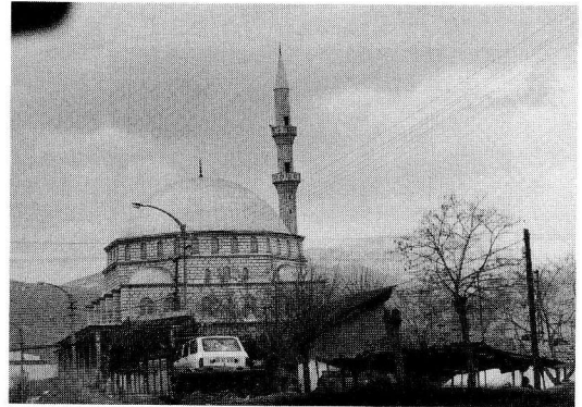
写真4 無被害のイスラム教会 尖塔は鉄筋コンクリート造であるが被害は報告されていない。
