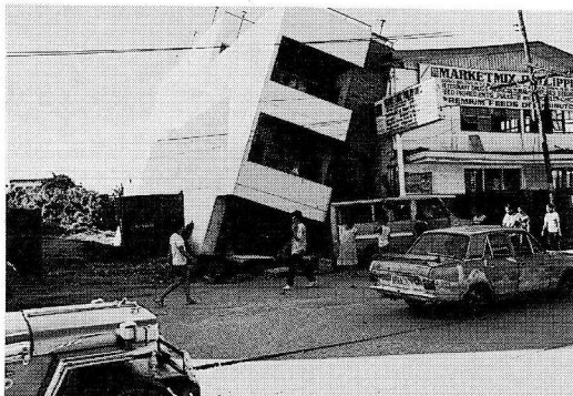
写真1 フィリピン・ルソン島地震 液状化による建物の傾斜。
