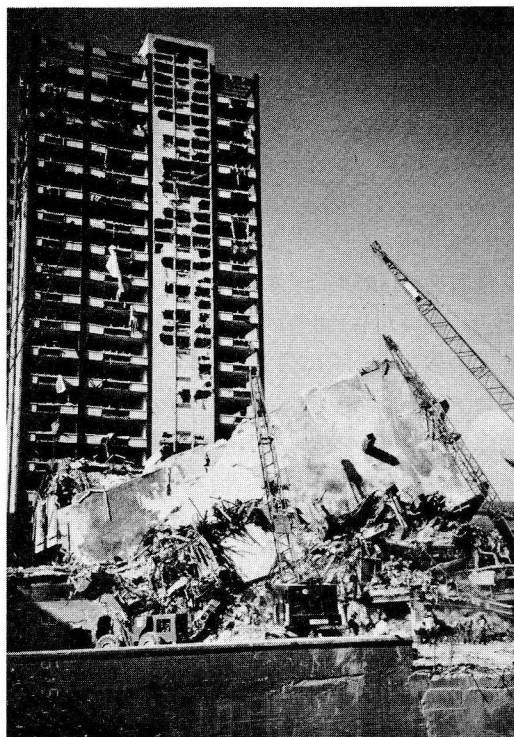
写真1 21階建鉄骨ビルが脇にあったビルの上へ横倒しになった。後方には別の21階建ビルが座屈し傾いている。
