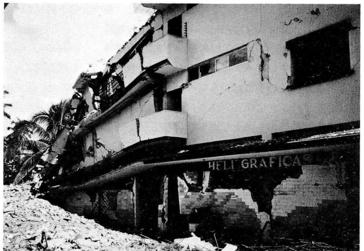
写真7 震源域に近いシワクネホの3階建オフィス兼ホテルは、本震によって壊れ、最大余震で倒壊した。
