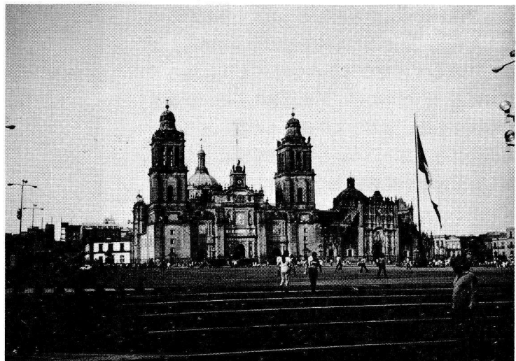
写真6 ソカロ広場に面した昔からの教会 地震の被害をほとんど受けなかった。
