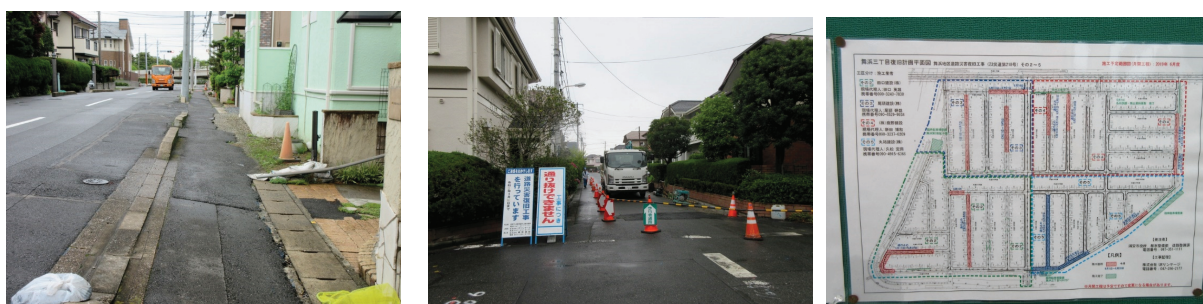
写真1 道路に対して歩道と宅地が後ろに沈んでいる 写真 2, 3 地震から 8 年経過して道路改修工事中
