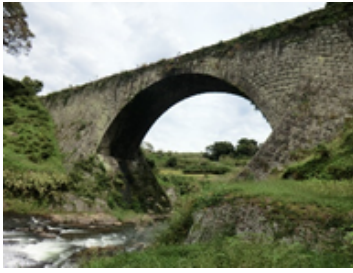
(a) 上流側からの外観
