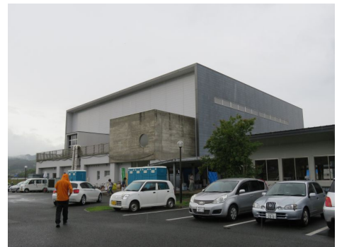
写真14 益城中央小学校
