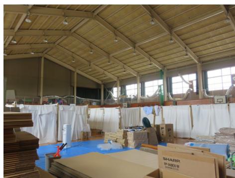
写真 11 広安小学校体育館、紙管フレームと布カーテン
