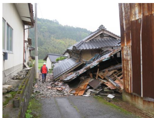
写真6 益城町堂園付近 (2016.4.23)
