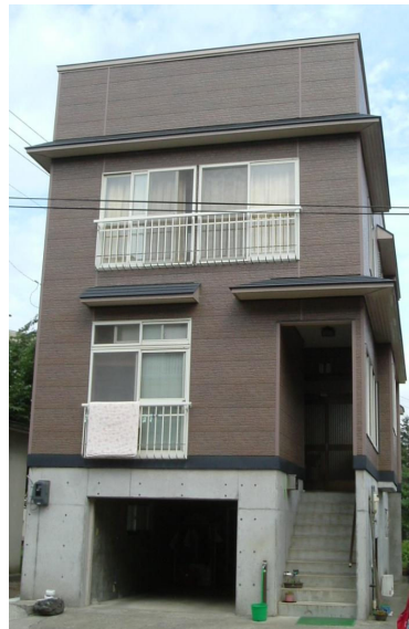
図 14 高床基礎の例
