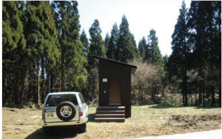
男鹿観測所観測小屋
