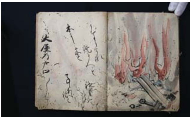
壊れた梁の下敷きになった被災者と火災の様子
